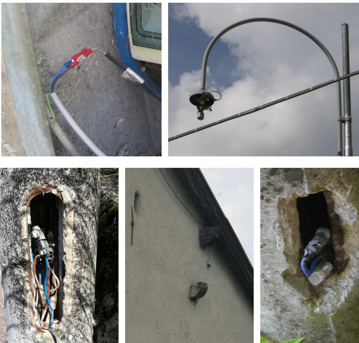
Fig. 22 – Situazioni critiche individuate per lo stato di conservazione dei collegamenti elettrici
